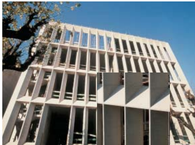
Veduta della facciata e particolare strutturale della Città della Musica e delle Belle Arti di Chambéry, in Francia, realizzata con TX Millennium a base di cemento grigio.
