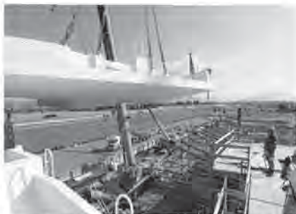
■ Conci anti-smog: il cantiere dell'ItcLab
