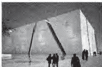
Un render del padiglione all'Expo di Shanghai. Il 40% dell'involucro sarà ricoperto dalle lastre traslucenti Italcementi.
