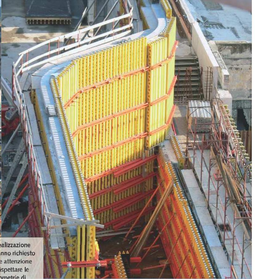
I getti per la realizzazione delle pareti hanno richiesto una particolare attenzione non solo per rispettare le complesse geometrie di progetto, ma soprattutto per avere un risultato finale monolitico. La scasseratura dei setti evidenzia la perfetta monoliticità del getto.
