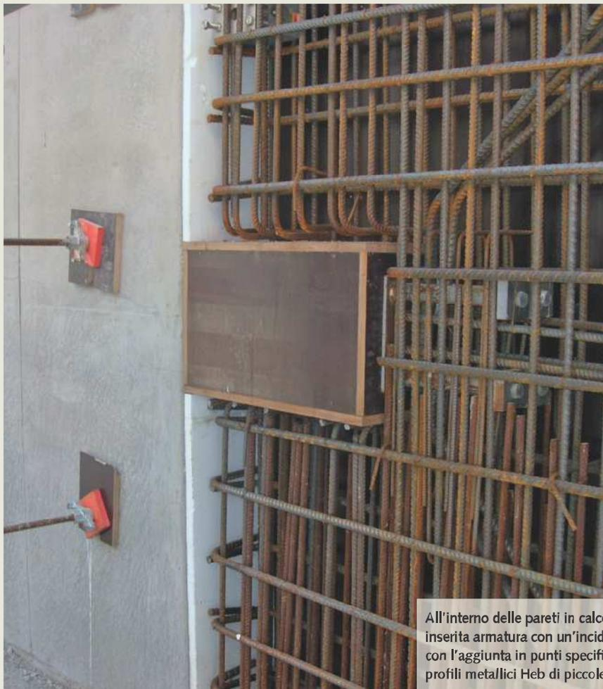
All'interno delle pareti in calcestruzzo armato è stata inserita armatura con un'incidenza di circa 300 kg/mq e con l'aggiunta in punti specifici maggiormente sollecitati di profili metallici Heb di piccole dimensioni di irrigidimento.
