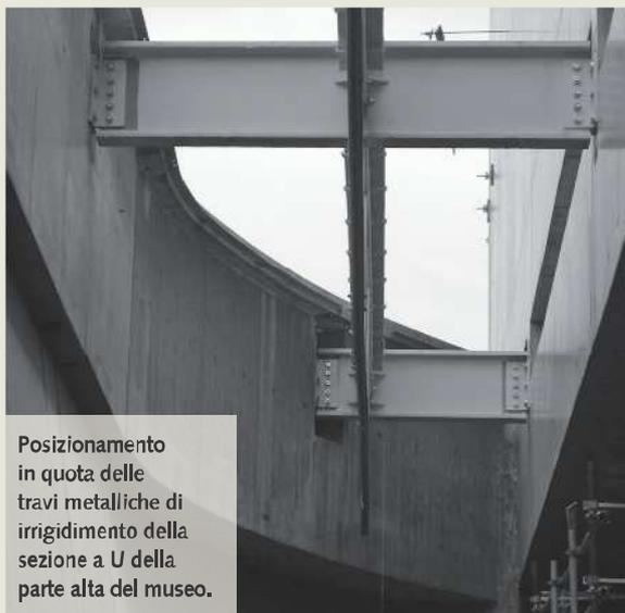
Posizionamento in quota delle travi metalliche di irrigidimento della sezione a U della parte alta del museo.
