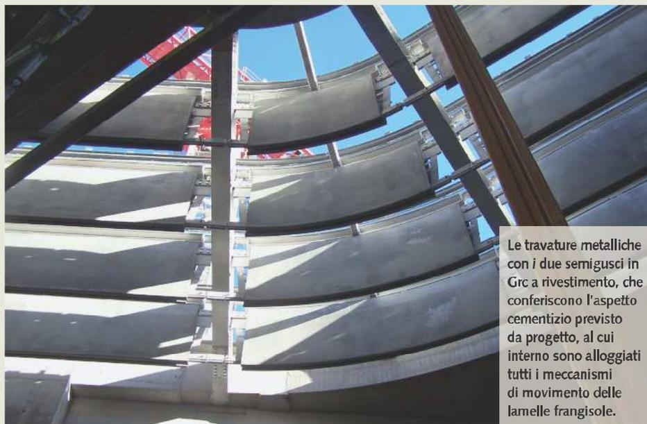
Le travature metalliche con i due semigusci in Grc a rivestimento, che conferiscono l'aspetto cementizio previsto da progetto, al cui interno sono alloggiati tutti i meccanismi di movimento delle lamelle frangisole.
