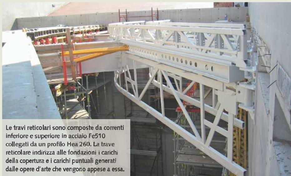
Le travi reticolari sono composte da correnti inferiore e superiore in acciaio Fe510 collegati da un profilo Hea 260. La trave reticolare indirizza alle fondazioni i carichi della copertura e i carichi puntuali generati dalle opere d'arte che vengono appese a essa.
