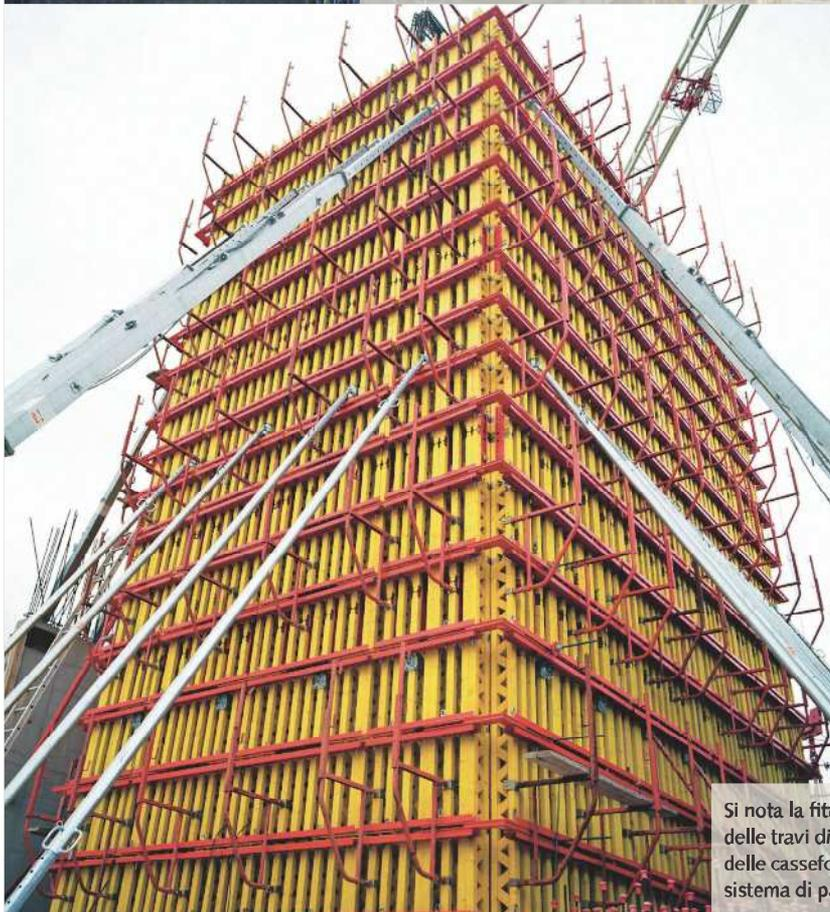
Si nota la fittitudine delle travi di sostegno delle casseforme e del sistema di puntellazione.
