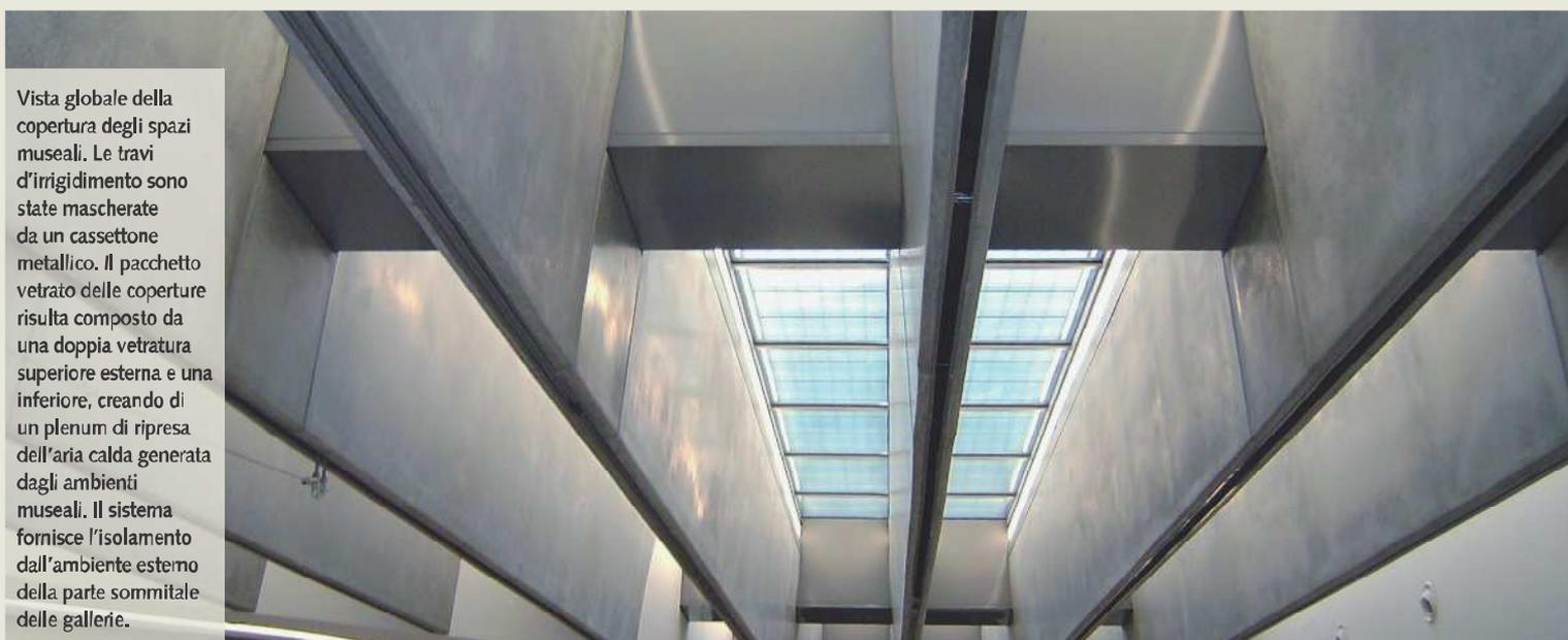
Vista globale della copertura degli spazi museali. Le travi d'irrigidimento sono state mascherate da un cassettoni metallico. Il pacchetto vetrato delle coperture risulta composto da una doppia vetratura superiore esterna e una inferiore, creando di un plenum di ripresa dell'aria calda generata dagli ambienti museali. Il sistema fornisce l'isolamento dall'ambiente esterno della parte sommitale delle gallerie.
