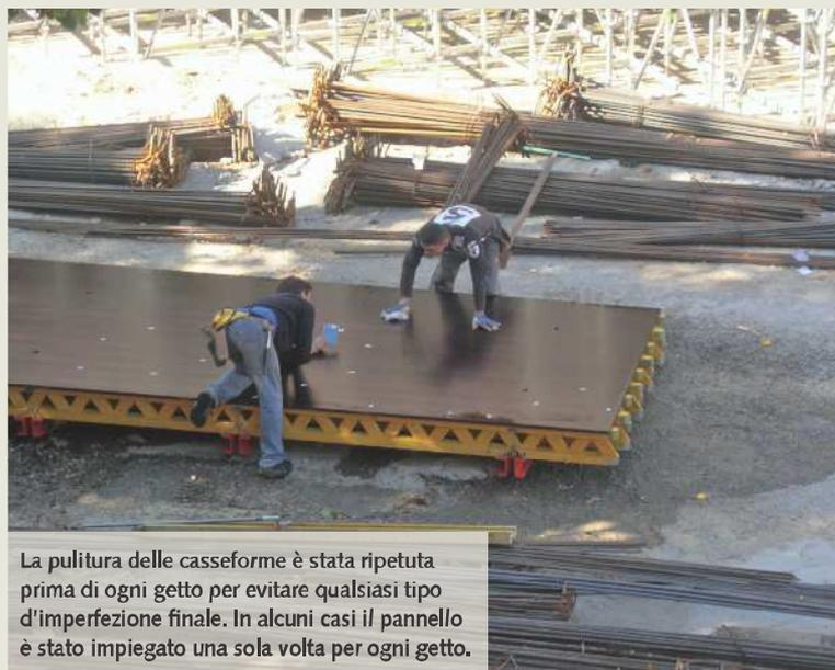
La pulitura delle casseforme è stata ripetuta prima di ogni getto per evitare qualsiasi tipo d'imperfezione finale. In alcuni casi il pannello è stato impiegato una sola volta per ogni getto.
