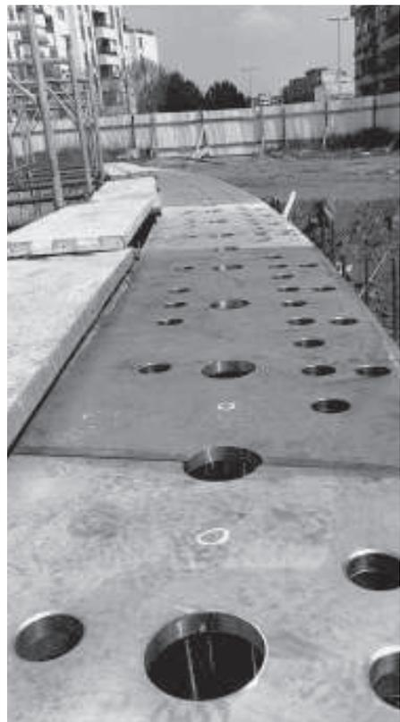
Il cantiere della chiesa di Tor Tre Teste a Roma nella fase iniziale dei lavori; nella pagina a sinistra, particolare della base su cui poggiano i conci delle vele in cemento, tenuti insieme da un sistema di cavi d'acciaio in tensione.
